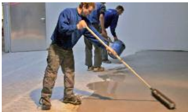
Zpracování UZIN NC 170 LevelStar na volně položeném renovačním rounu UZIN RR 201
